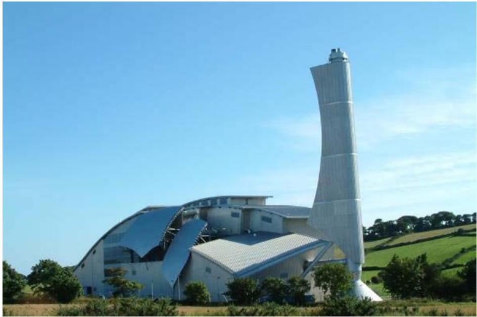
Incinerateur_Isle of Man
