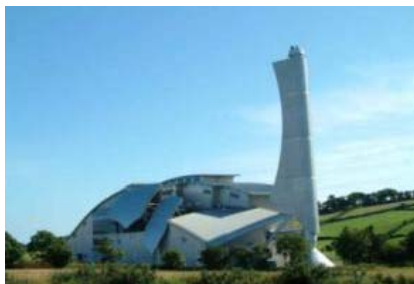
Centre de traitement des déchets
